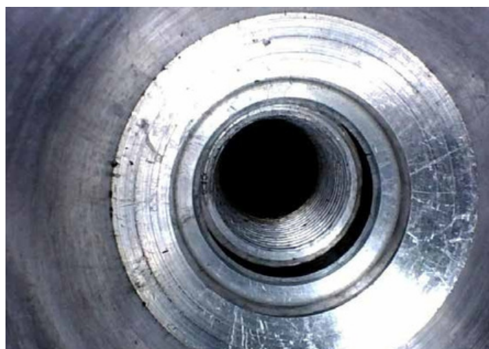
Foto superior: Inspección del puerto de la bujía
